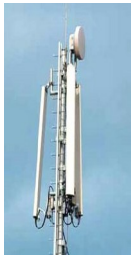
Typische Mobilfunkbasisstation mit drei Sektorantennen und Richtfunk
